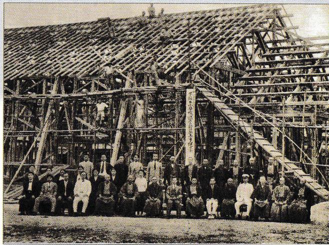
**写真5** 昭和10年に撮影された下阪本小学校講堂(体育館)新築工事の様子。当時の建築工法がわかる貴重な写真。
