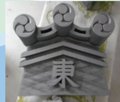
東南寺：割れた鬼瓦を新しく復元
